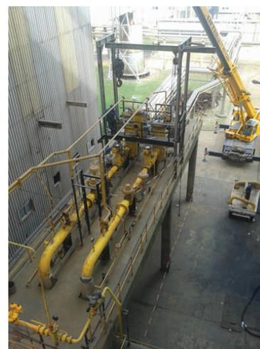
Se inició el Mantenimiento Integral Plataforma de Gas reductora /reguladora de Caldera N°3 y N°4. La obra consiste en el desarme y repaso de todas las válvulas interceptoras, reguladoras y de seguridad.
