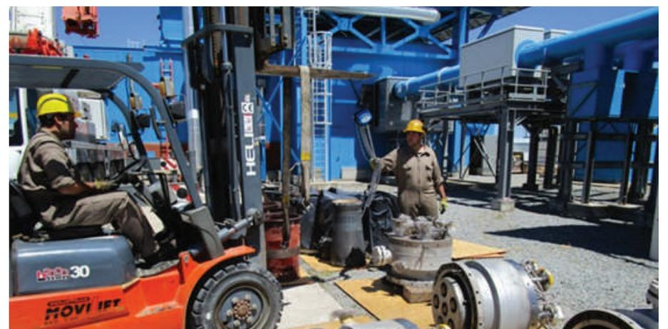
Para este mantenimiento se realizó una gran inversión en repuestos y herramientas especiales, acordes a la calidad que esta tecnología requiere. Se llevó a cabo en base a las horas de funcionamiento, las recomendaciones del fabricante –que también participó de la asistencia técnica– y las inspecciones mediante videoscopio que se realizan en la Central.
