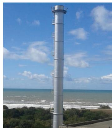
La reparación integral de la Chimenea de Caldera TV4, se encuentra en su etapa de finalización. La obra consistió en la reparación y repaso total de la aislación interior refractaria, reparaciones metalúrgicas de la estructura principal, escaleras, plataformas y soportes de conducto de humos, arenado y pintado total.
